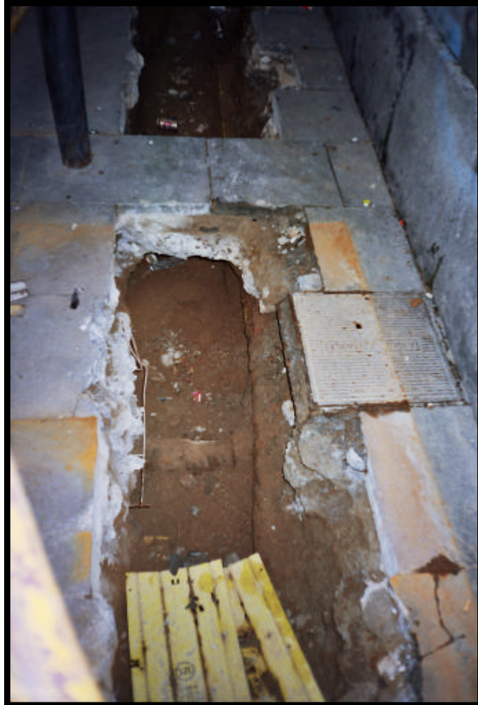
Detall on s'aprecia el nivell de reompliment U.E. 300 Carrer Lancaster, 22-24
