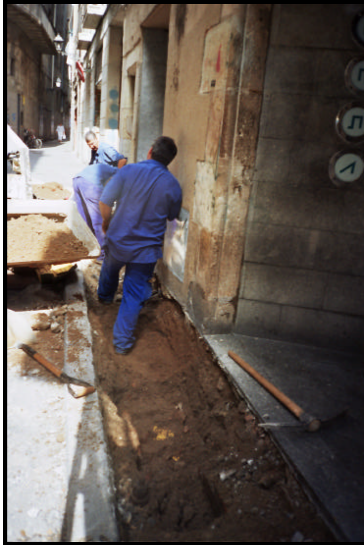
Obertura de la rasa al carrer de l'Arc del Teatre, 3-5
