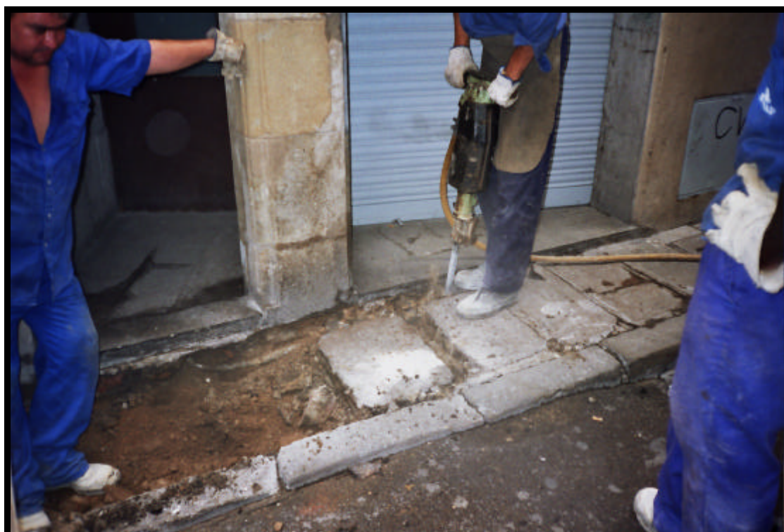
Obertura de la rasa al carrer de l'Arc del Teatre, 3-5
