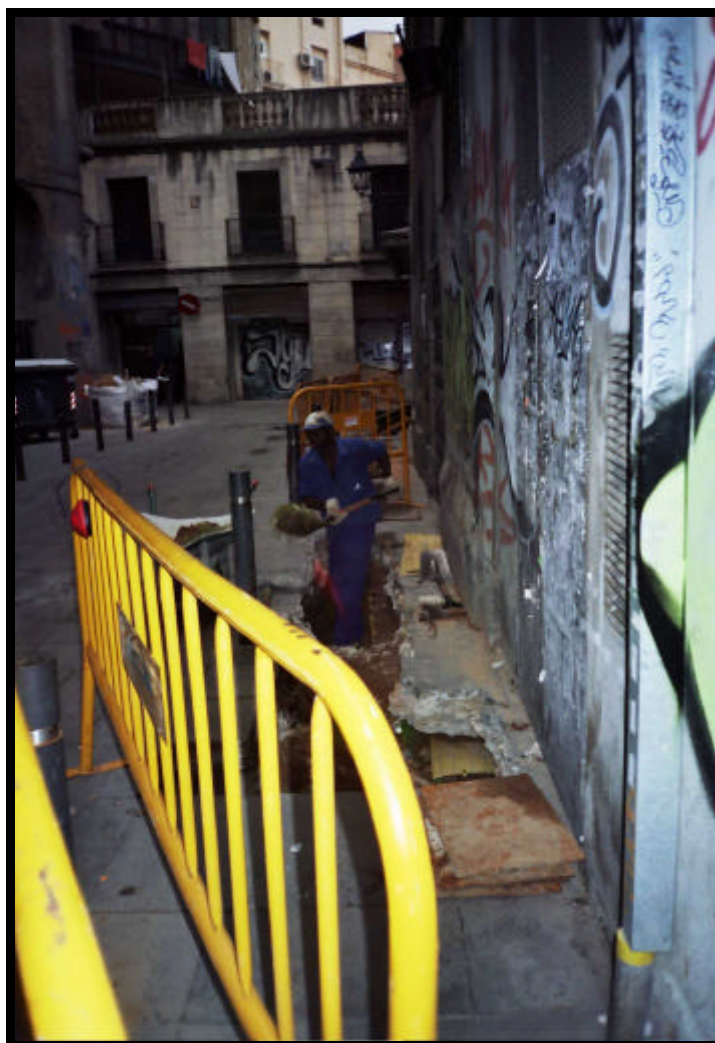
Obertura de la rasa al carrer Lancaster, 22-24
