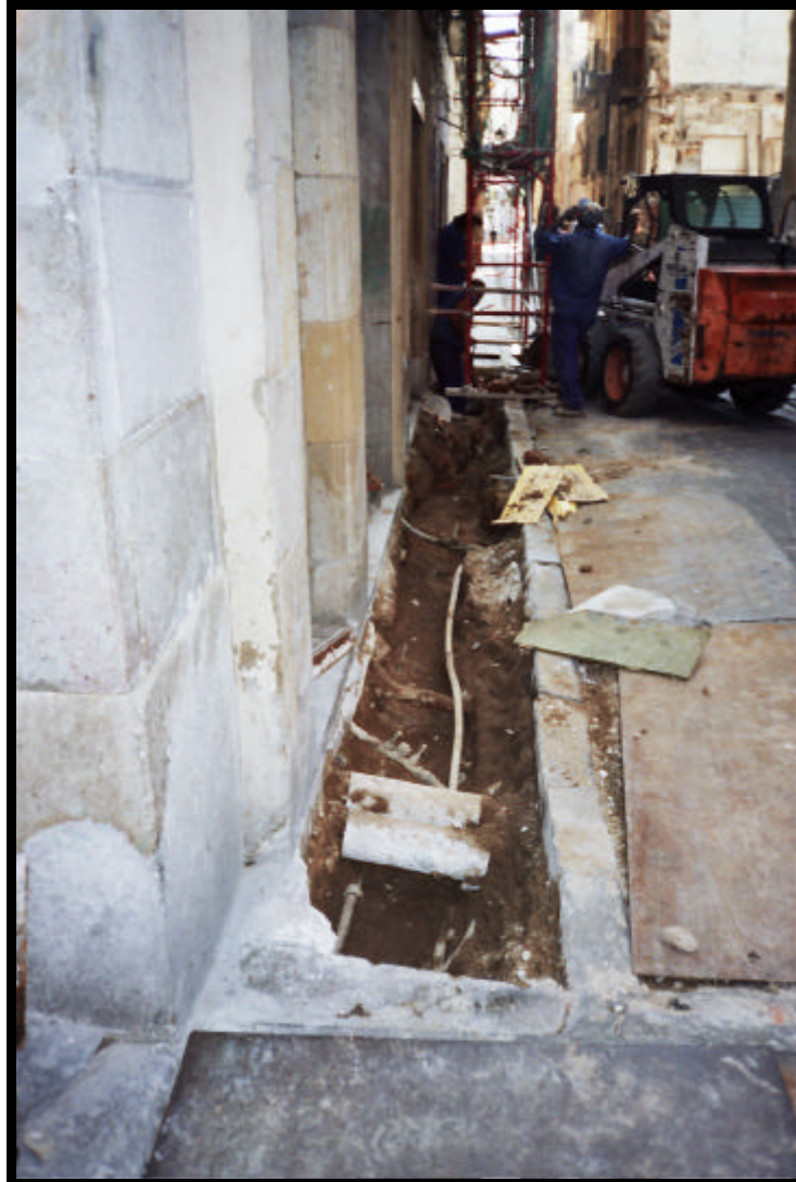
Detall on s'aprecia la gran quantitat de serveis Carrer de l'Arc del Teatre, 3-5
