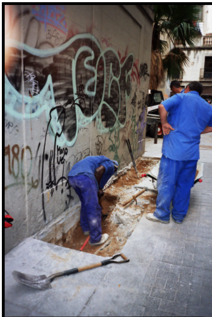
Obertura de la rasa al carrer Lancaster, 13-19
